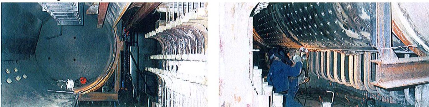
Vattenskärning av mantelplåt
